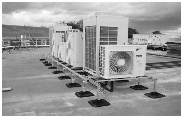
Рис. 4. Вынос сплит-системы на крышу здания
