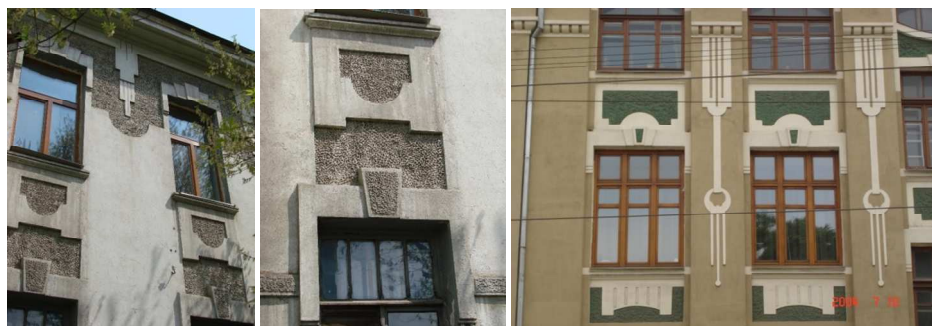
Рис. 5. Характерное использование гладкой и грубой штукатурки
