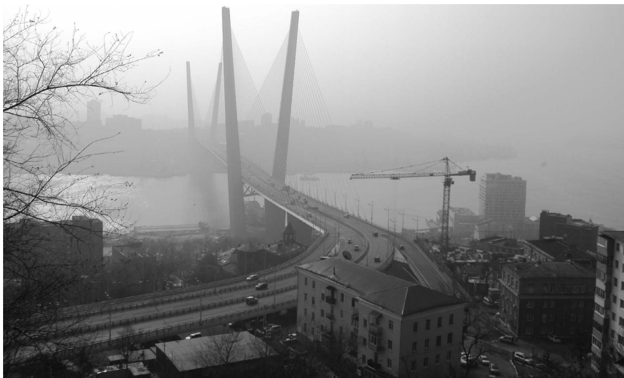
Мост через бухту Золотой Рог в г. Владивостоке (фотография Н.Е. Богдановой)
