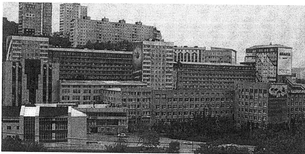
Рис. 1. Общий вид кампуса ВГУЭС
